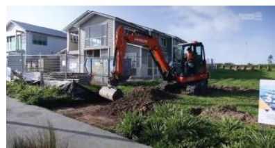
良好的建筑工地管理
