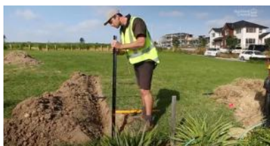
建立拦砂网及围堰
