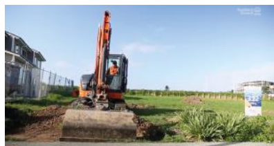
稳固出入通道
