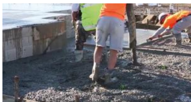
混凝土的使用
