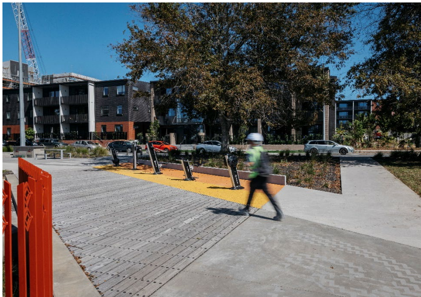
位于 Northcote，俯瞰 Greenslade 保护区的新建项目
