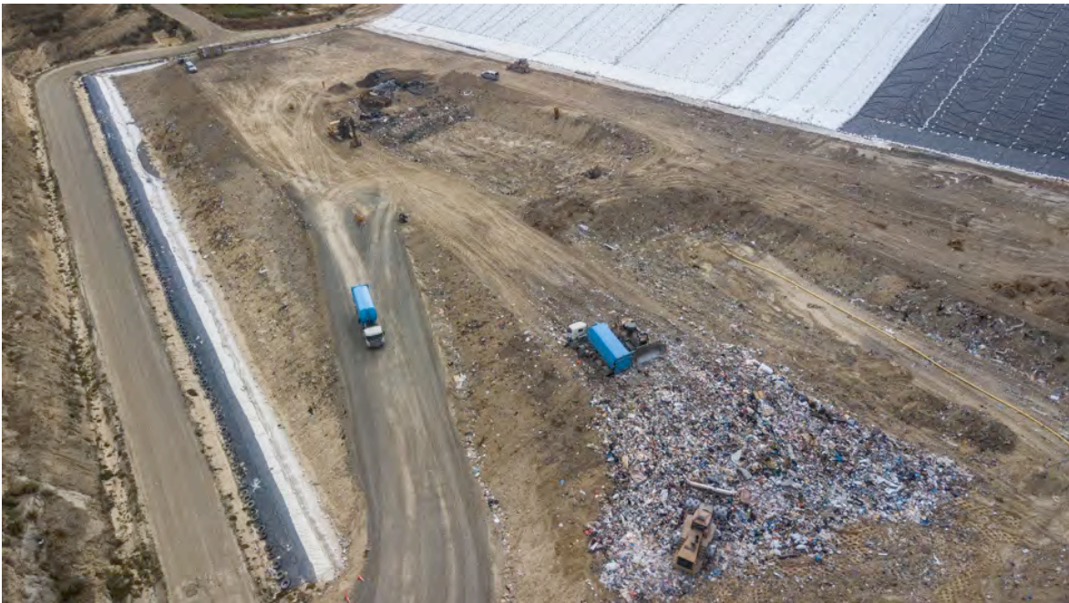
Below: Landfill Cells
